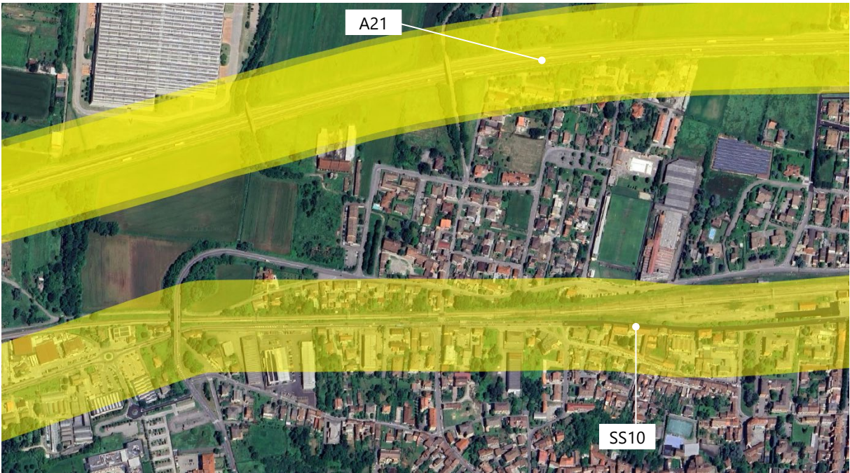
Figura 3.27. Esempificazione delle fasce a maggior concentrazione di inquinanti lungo la A21 e la SS10 con coinvolgimento di tessuti urbani e abitazioni sparse o isolate.
